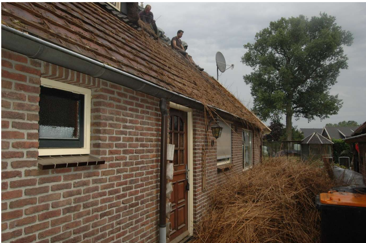
28 juli 2018, riet en pannen eraf, er komt nieuw riet op het dak
