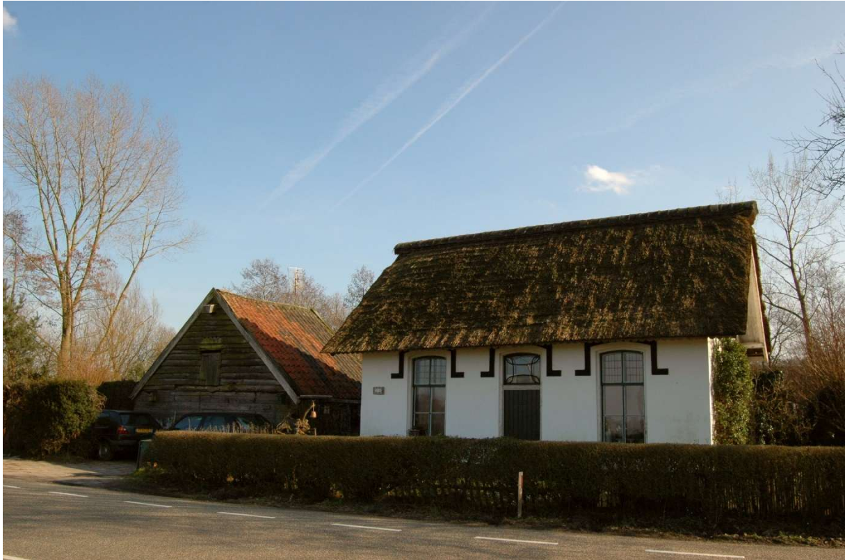
Voormalig tolhuis (eerder school Enterbroek), Wierdenseweg
