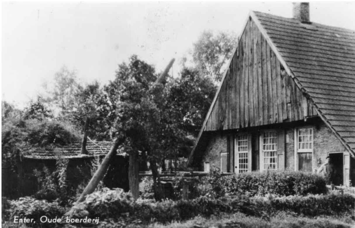
Erve de Oldenhof aan de Lagedijk
