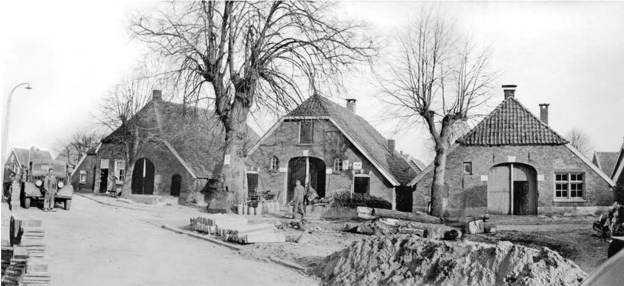
1961, aanleg trottoir op de Hogebrink
